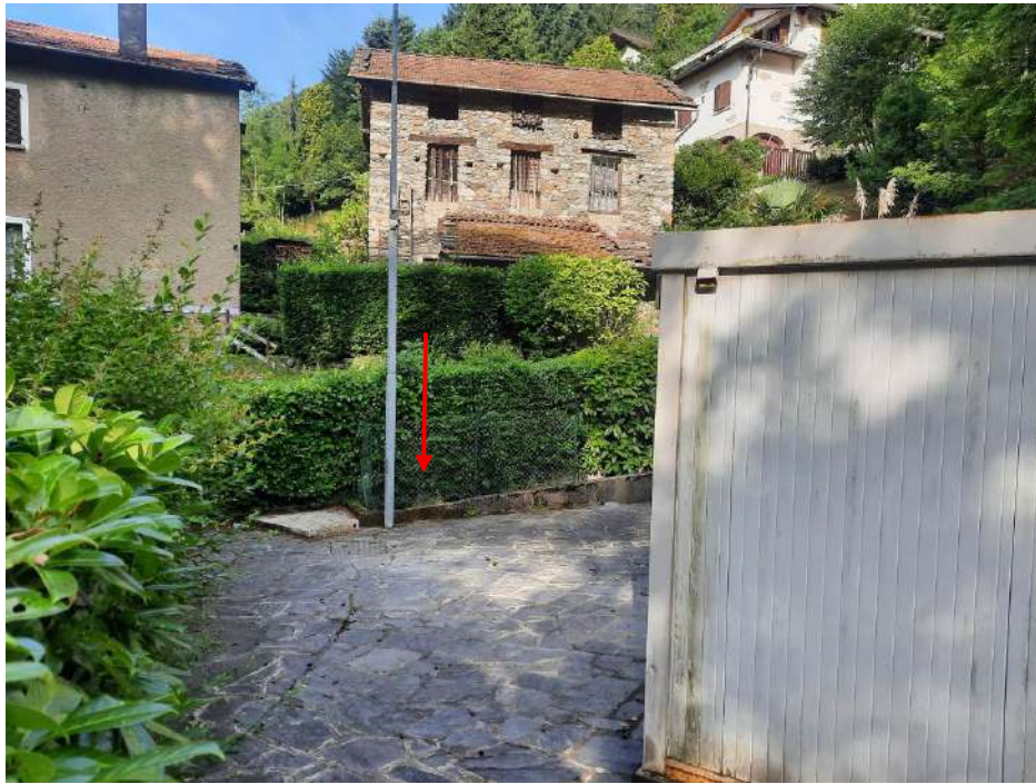
Figura 8 – Punto di tombinatura del corso d'acqua (freccia rossa), posto entro area privata recintata.
