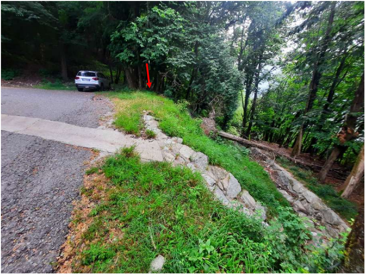
Figura 3 – Attraversamento Valle di Pezzo in corrispondenza della pista per i monti di Breglia. Particolare del nuovo canale per il reindirizzamenti di eventuali tracimazioni del deflusso idrico in alveo. La freccia rossa indica la posizione della tombinatura dell'alveo.
