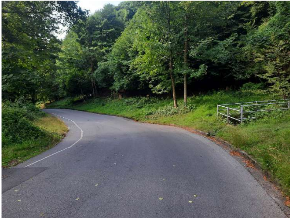
Figura 10 – Intersezione asta torrentizia (valletto di Bull) con la strada comunale per Breglia
